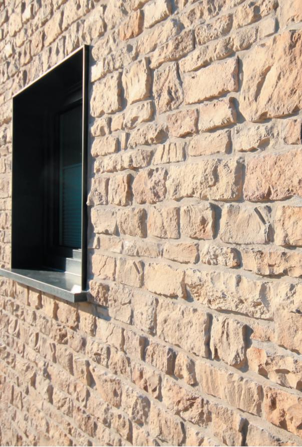
EASY-WALL ist ein vorgefertigtes Verblendersystem, bestehend aus einer Schicht Betonverblender, die in eine Platte aus Polyurethanschaum eingefasst sind (PUR).
